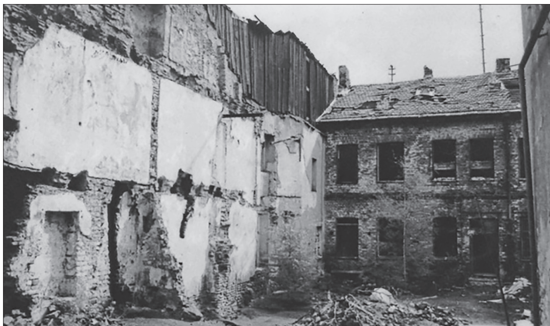
Miško brolių draugijos pastatas iki rekonstrukcijos. 1992 m. A. Kentros asmeninis archyvas
