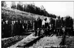
Telšių–Kretingos geležinkelio statyba.
